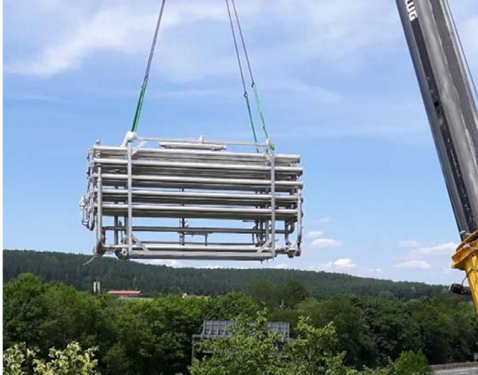
Einbringung der zweiten RO High<sup>TS</sup>-Anlage zur Aufkonzentrierung von Molke
